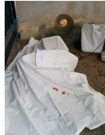
盗難対策のため放送関連装置を シートで隠した
