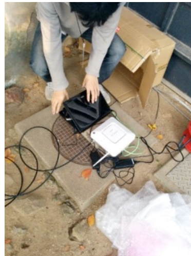
放送用アンテナ設置の様子
